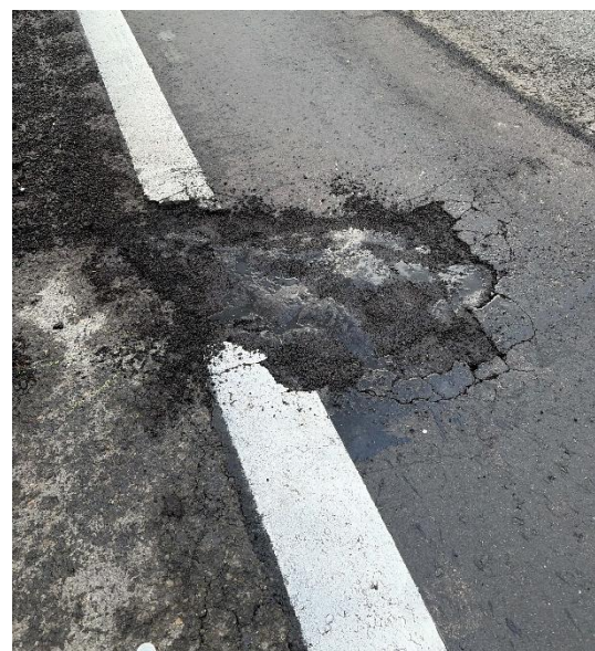
路面の損傷状況
