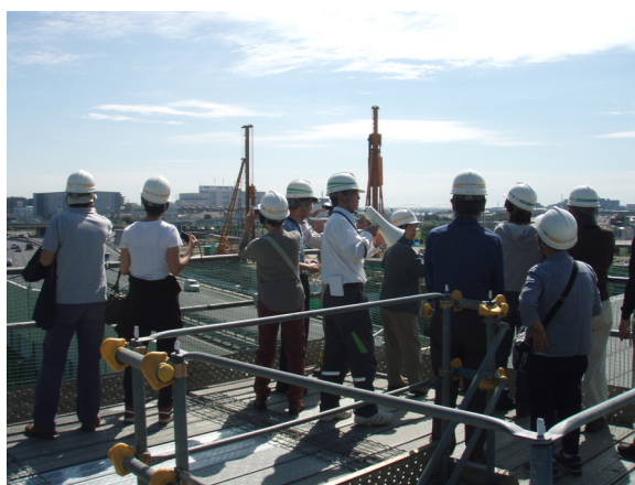
仮橋上のお立ち台から京葉JCT工事を見学
