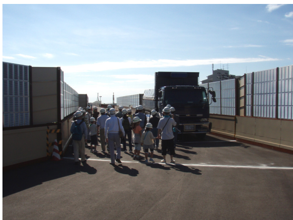
実際にダンプを設置し運用イメージを確認
