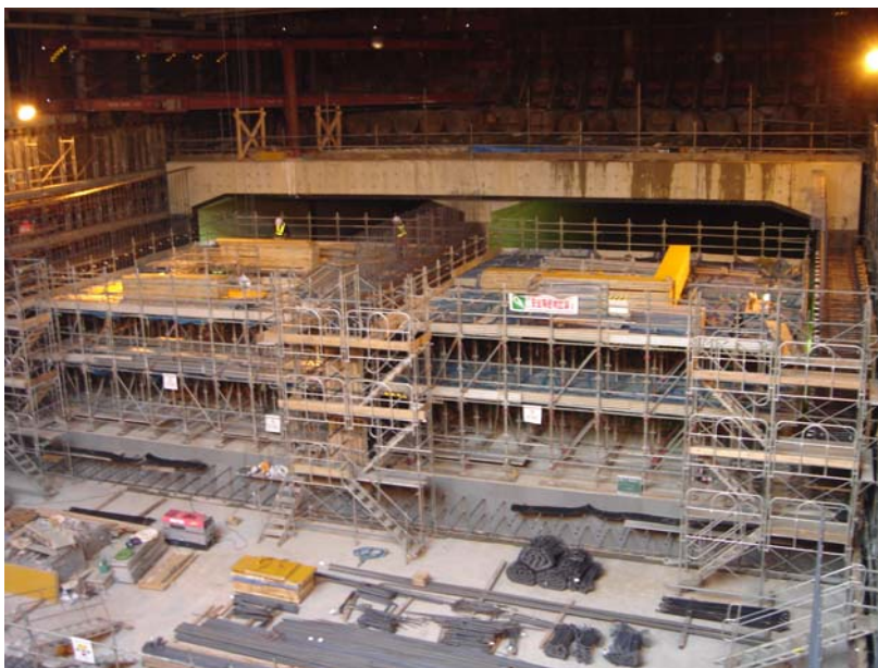
小塚山トンネル工事
