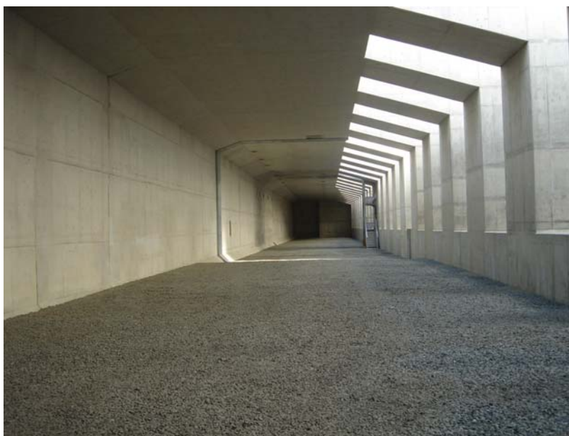
国分地区掘割部試験工事
