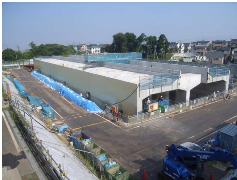
北総線交差部工事
