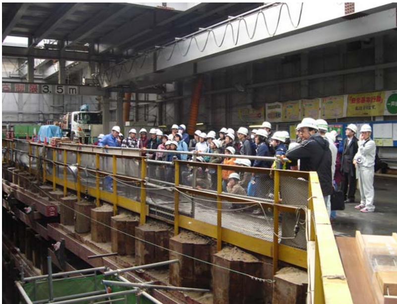
小塚山トンネル工事
