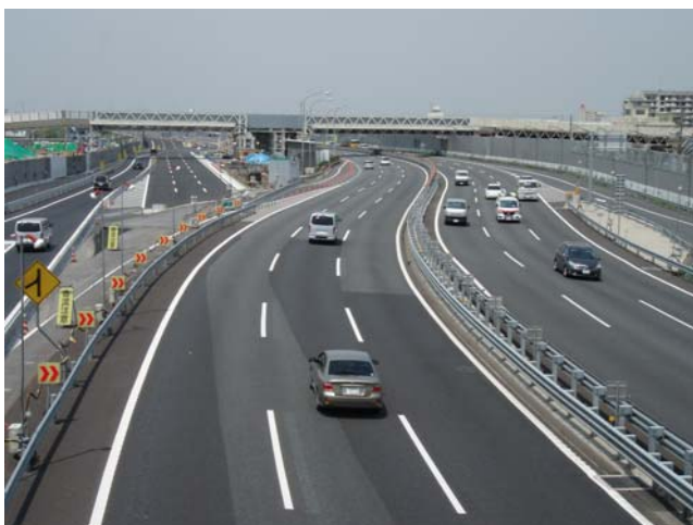
京葉道路(上り線)車線切替前
