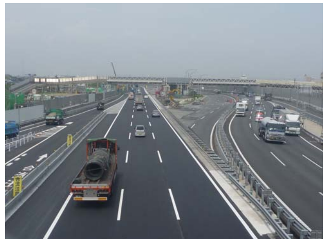
京葉道路(上り線)車線切替後
