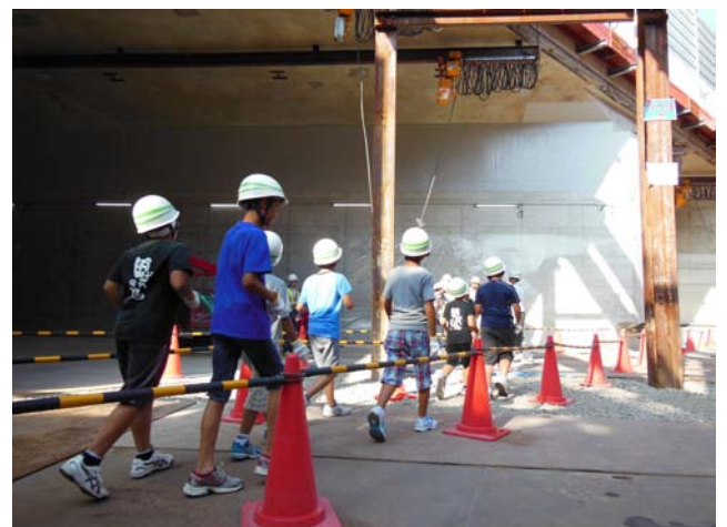
【京葉JCT地下】 一部完成した函体を見学。
