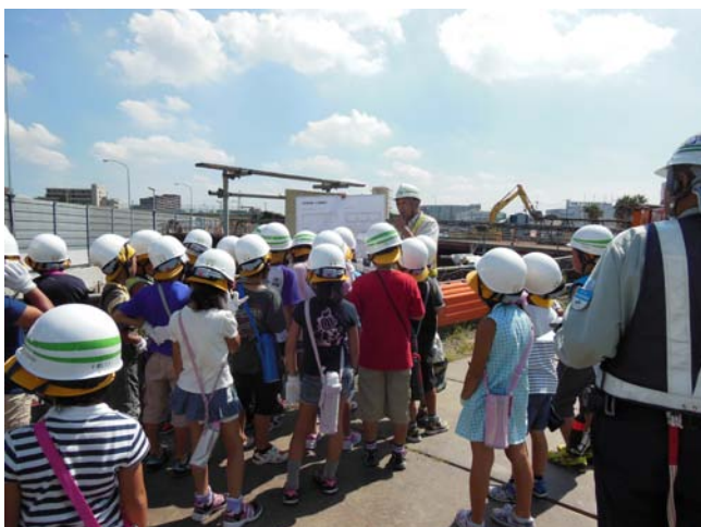
京葉JCTの函体を地上から見学
