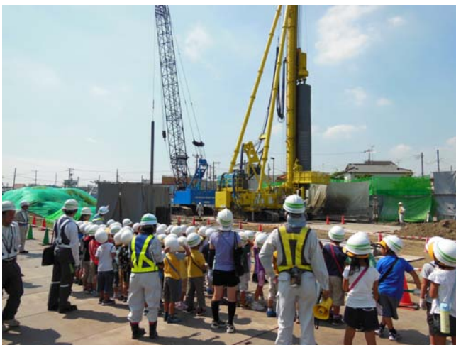
地中連続壁の施工を行う“はたらくるま”を見学
