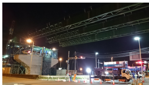
写真-2. P160 に向けて桁が伸びていきます
