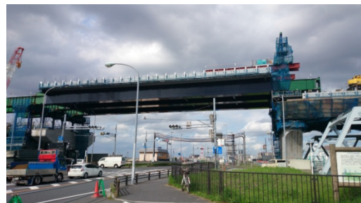
写真-4. 所定の位置まで送り出されました この後降下作業に移ります
