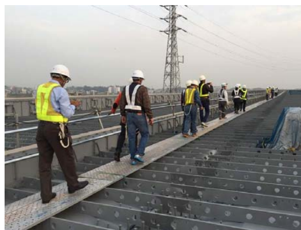
写真-2. 合成床版の上で。 現場にも風景にも興味津々。
