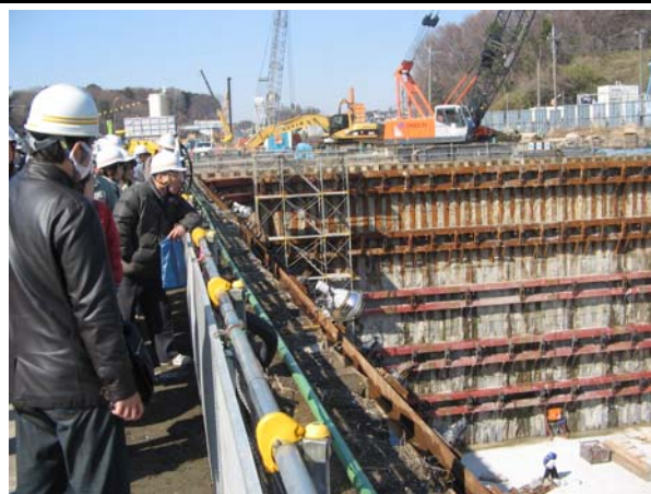
⑤堀之内地区函渠工事
