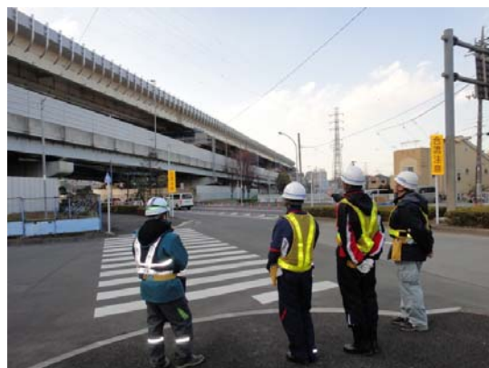
写真二. 送出し架設で架けられた橋を見学中。 夜中に少しずつ、橋げたが前へ伸びていきます。
