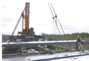
【新設床版の設置】
