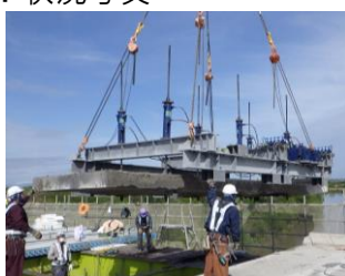
【既設床版の撤去】
