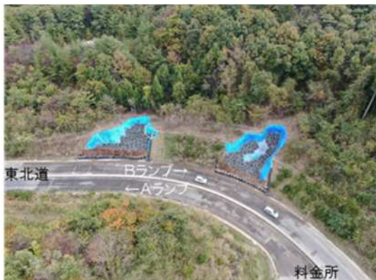
応急復旧状況
