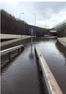
JCT内冠水時の状況
