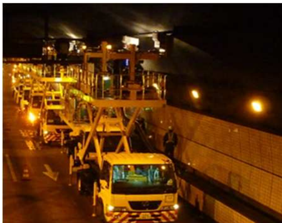
構造物点検状況
