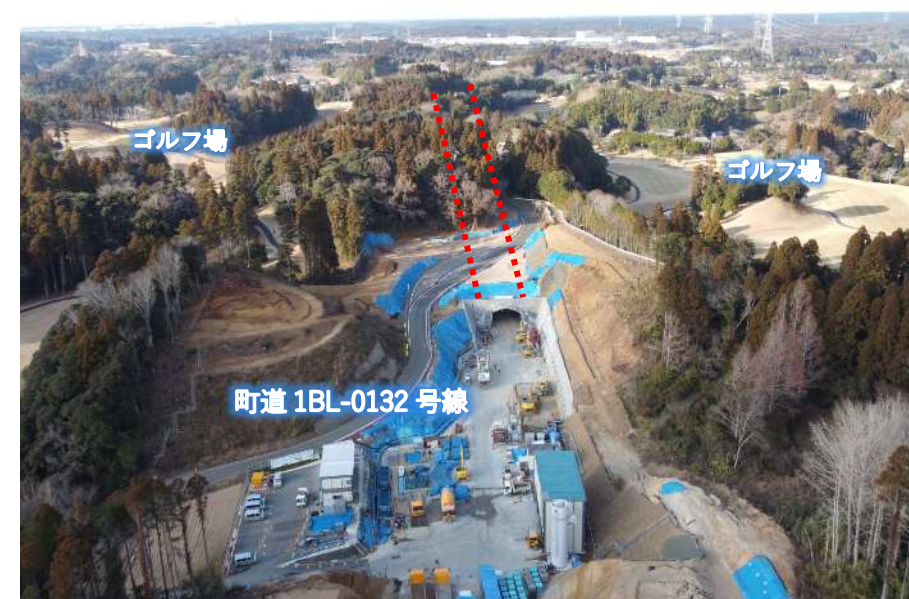
終点側坑口部 (掘削開始側)
