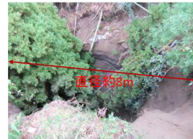
直径約8m、深さ約10m
