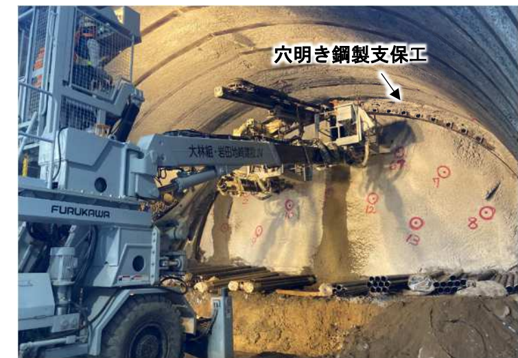
最小拡幅方式の施工状況（参考）
