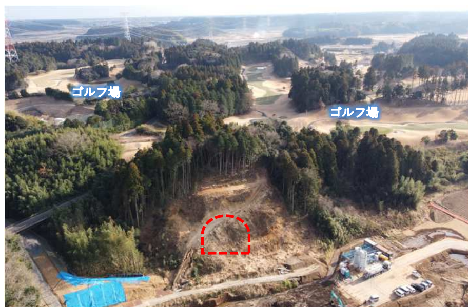
起点側坑口部 (到達側)
