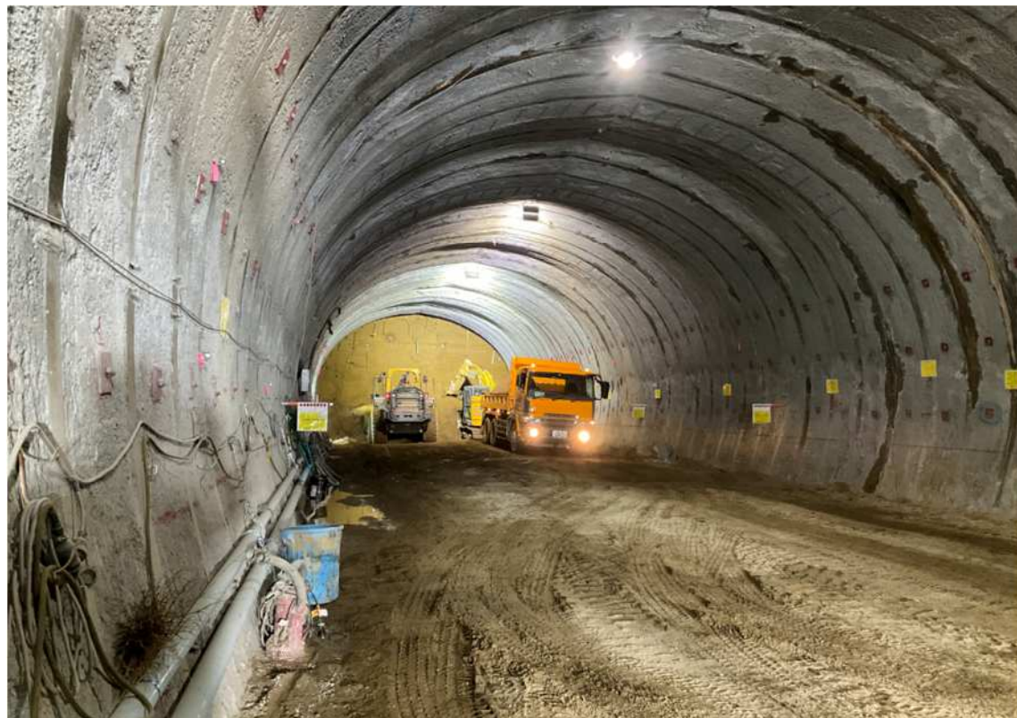
トンネル坑内状況写真
