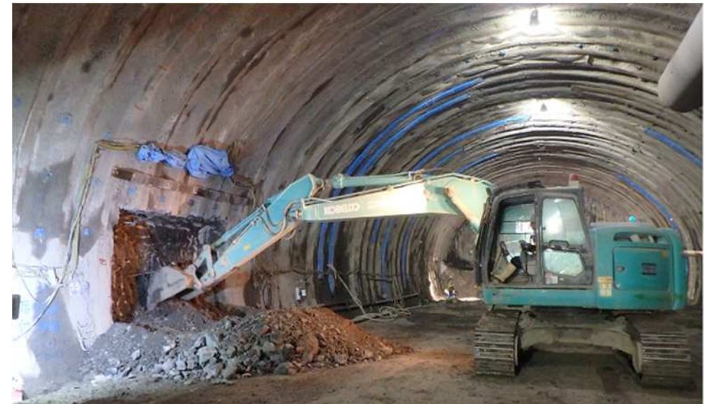
非常用設備用箱抜き掘削状況（例）
