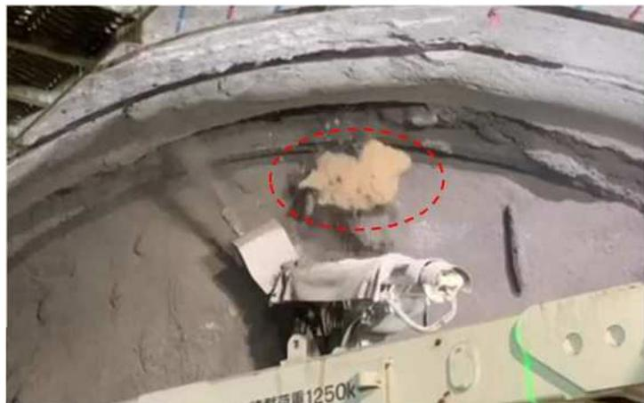
吹付け時の地山とコンクリートの抜け落ち状況
