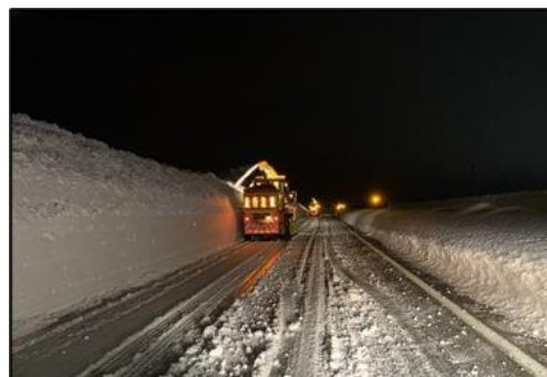
ロータリー除雪車による車線確保作業状況
