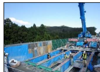
【古い床版撤去状況】
