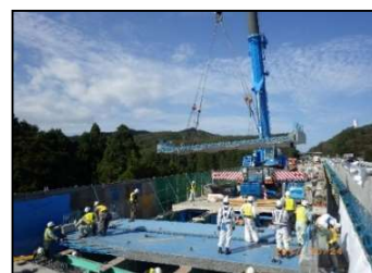
【新しい床版設置状況】
