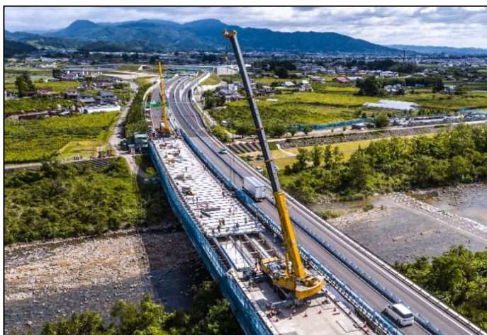
【対面通行規制状況】
