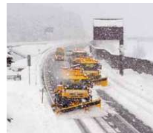
除雪作業状況
