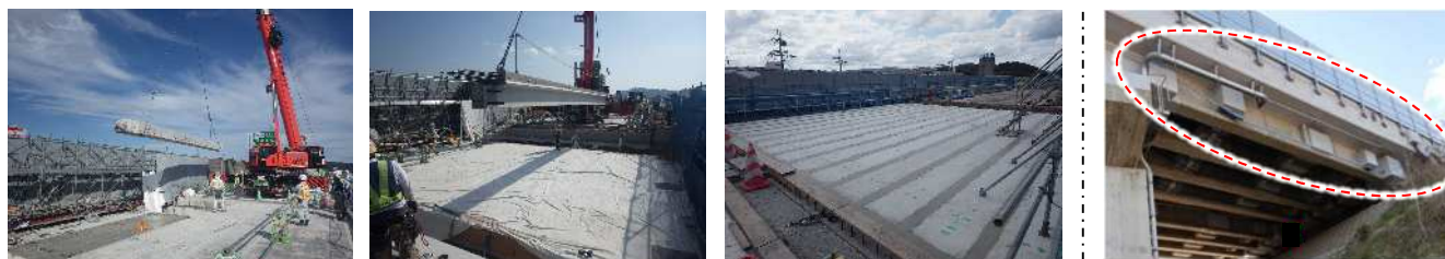
桁の切断・撤去
