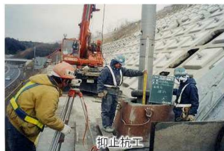
グラウンドアンカー工
