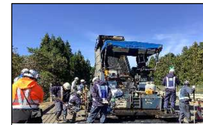
高耐久路盤敷設 ➢アスファルトフィニッシャーにより敷き均し
