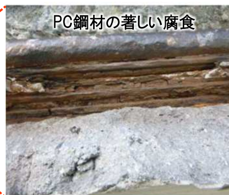
PC鋼材の変状状況
