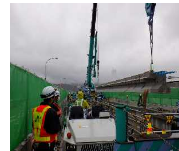
対策イメージ(桁の架替)
