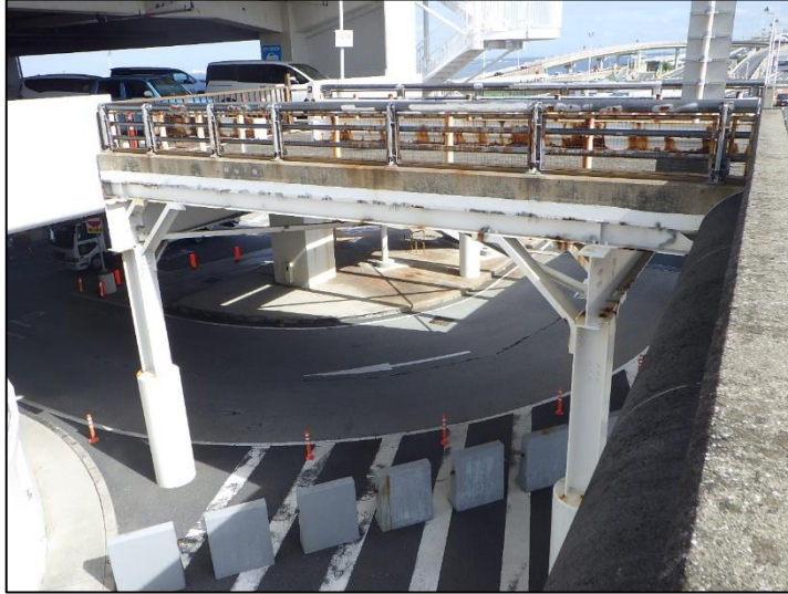
撤去する連絡橋
