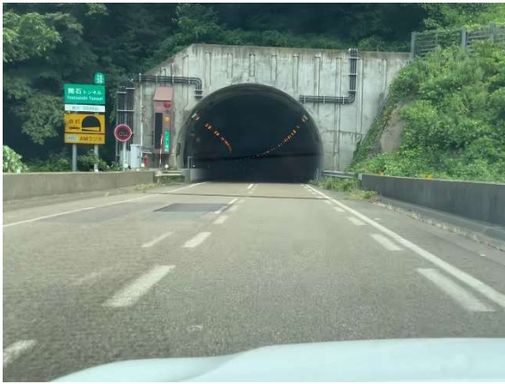
ロードヒーティング埋設箇所
