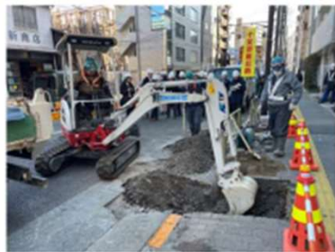
GX建機の実現場での活用事例
