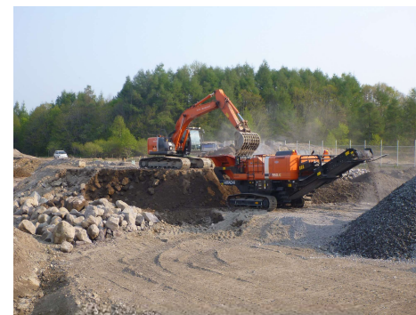
現地発生材の再資源化状況
