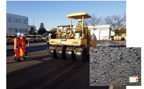
試験施工状況（合材温度30℃低減）
