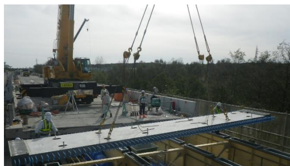
【新設床版の設置状況】
