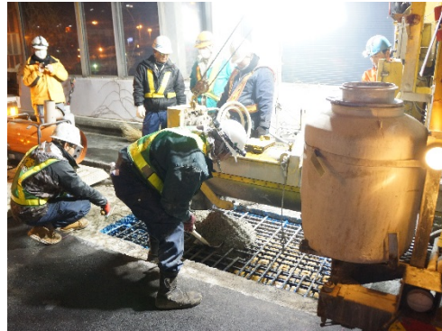
床版補修工事 作業状況
