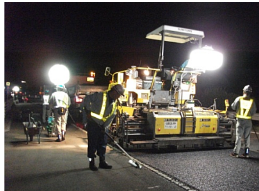
舗装補修工事 作業状況
