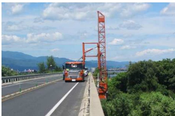
<橋りょう点検>
