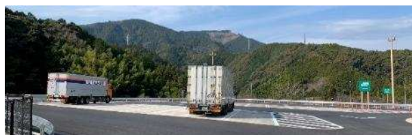
拡張した大型車エリア(E1A 新東名 静岡 SA(上り))
