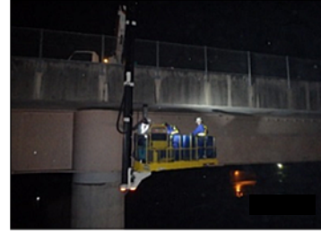
道路構造物点検状況
