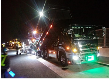
舗装補修状況
