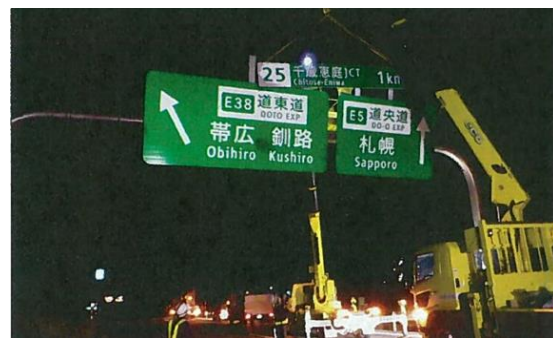
標識補修工事例
