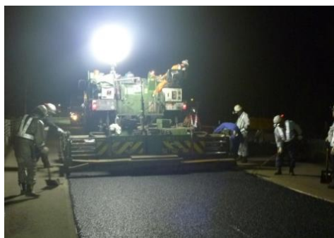
路面補修工事例
