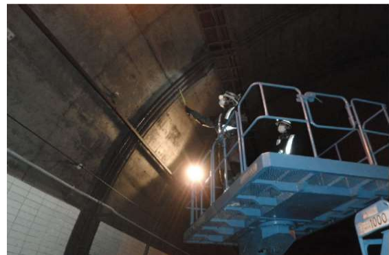
トンネル設備点検の状況(安田IC～津川IC間)
