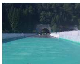
【床版防水工事】
