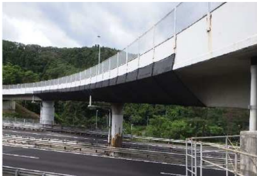
仙台宮城IC 下り線出口ランプ橋(折立橋)現況写真
