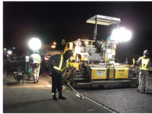
舗装補修工事 作業状況
