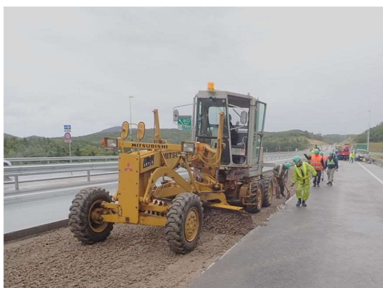
下層路盤補修例
