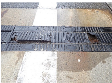
伸縮装置 現況
