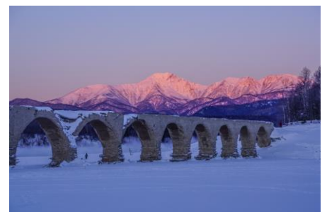
タウシュベツ川橋梁（上士幌町）
