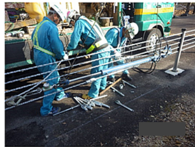
施工イメージ
