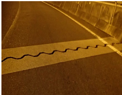
伸縮装置現況
