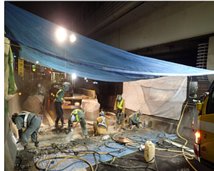
伸縮装置取替工事 作業状況
