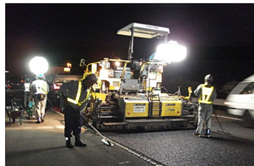
舗装補修工事 作業状況
