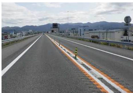
簡易中央分離帯の撤去
