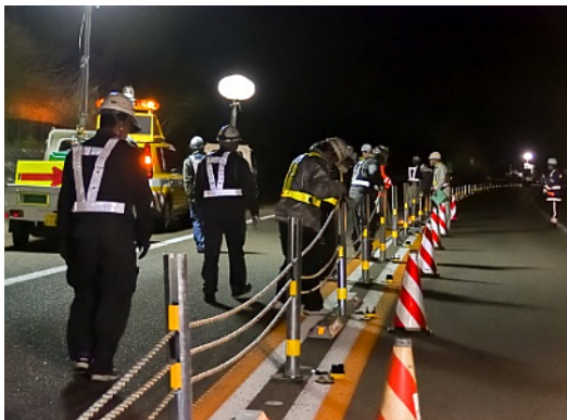
ワイヤロープ設置工事 作業状況
