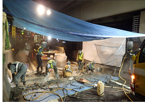
伸縮装置取替工事 作業状況
