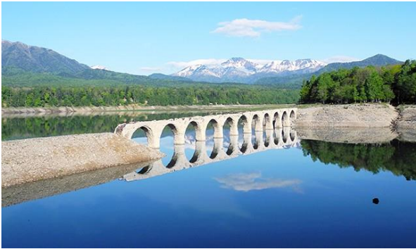
タウシュベツ川橋梁（上士幌町）
