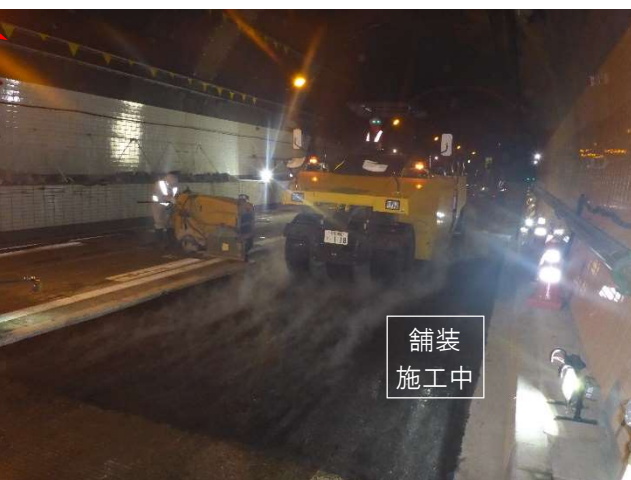
④埋め戻し後舗装の施工
