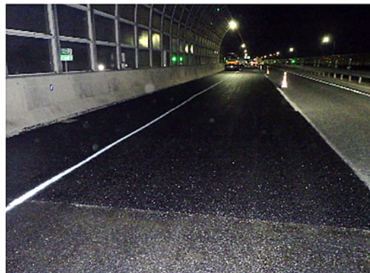
舗装補修後 イメージ
