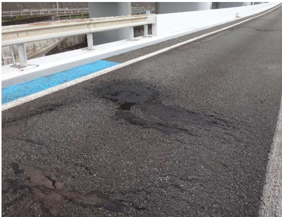
路面の損傷状況
