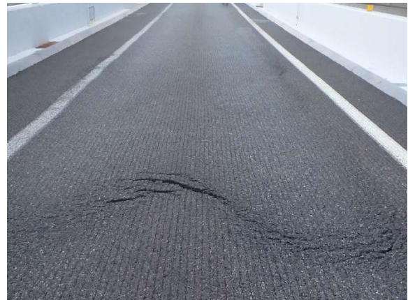
路面の損傷状況
