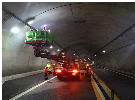
道路構造物の点検作業状況
