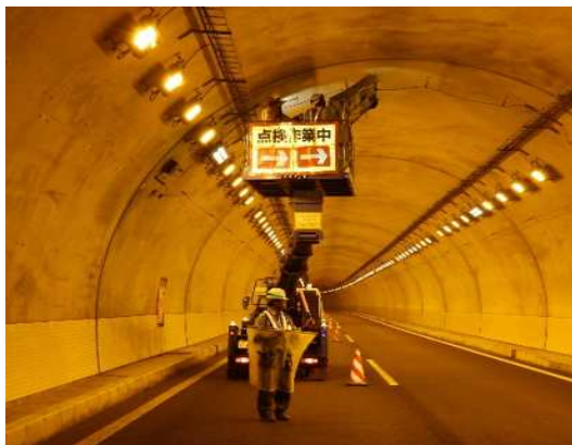
トンネル点検
