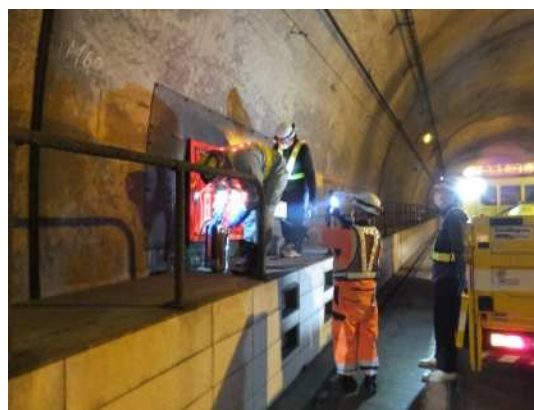
トンネル設備点検
