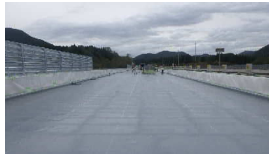
【床版防水工事】
