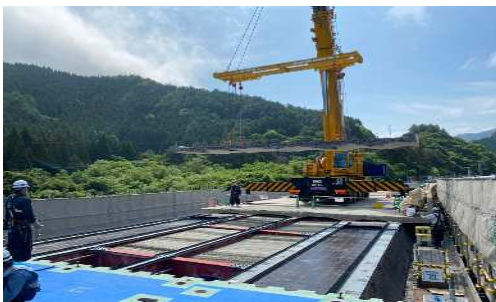
【床版取替工事】
